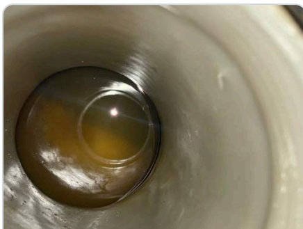
Parte / Estanque de combustible
