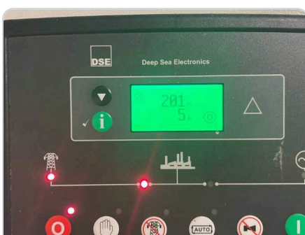
Parte / Transferencia automática ATS
