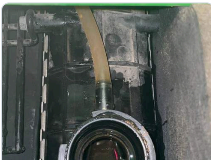
Parte / Sistema de refrigeración
