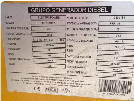
Equipo / Generador data del generador
